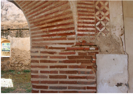
Zona de degradación de los materiales constitutivos.
